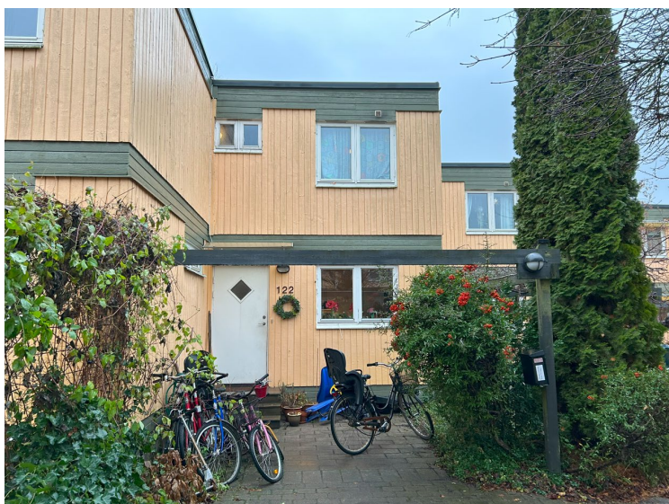
Ursprunglig byggnad har sidohängda tvålufts-fönster med fast mittpost. Vanligast förekommande dörr i området är vit enkeldörr med rombfönster.
