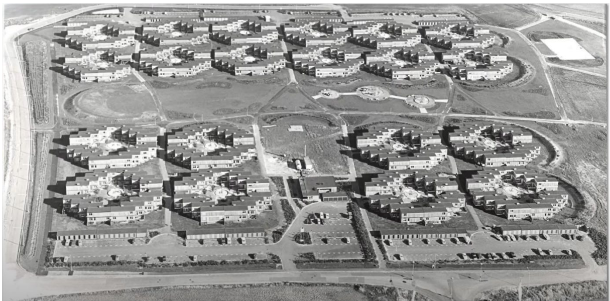
Flygfoto 1973. Här syns "gillestugan" nu kallad Vita huset, som innehöll lokaler för matbutik, samlingslokaler, pub, tvättstuga och vaktmästeri. Ovanför syns även oljecistern och panncentral på den plats där förskolan Oljan byggdes 1974–75. De runda formerna i Bananparken är lekplats och fotbollsplaner. Källa: Lunds stadsarkiv.
