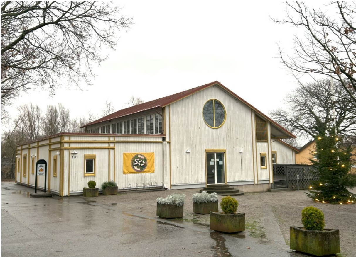
Vy från centrumbildningen mot öster. Nuvarande utformning efter ombyggnad 1991.
