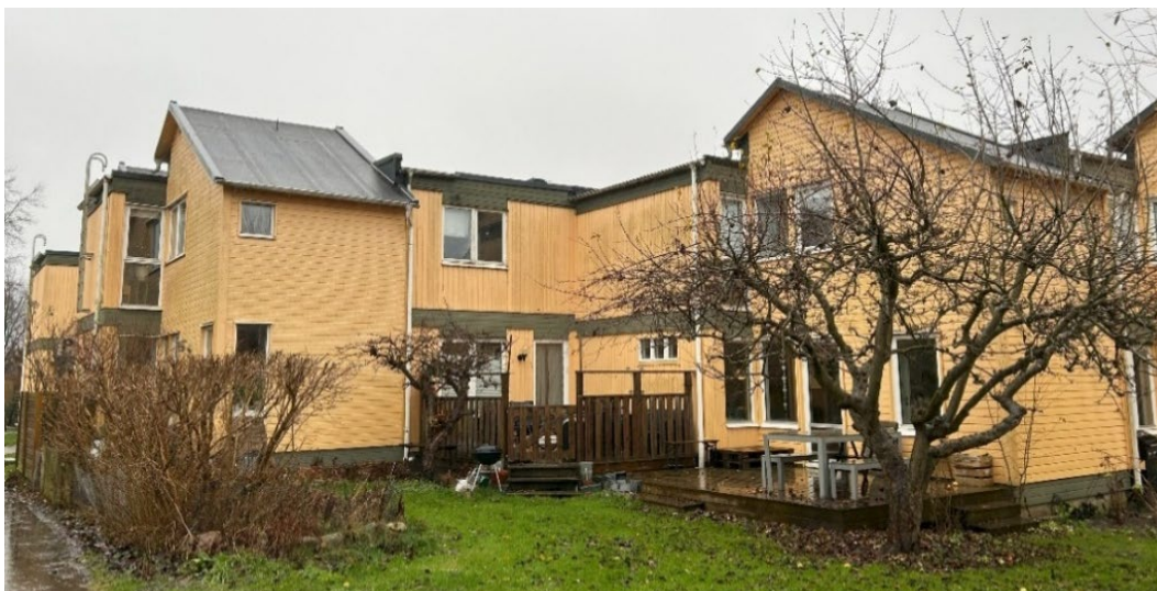
Tillbyggnaderna med fasader av liggande träpanel möter ursprunglig byggnad med stående träpanel.
