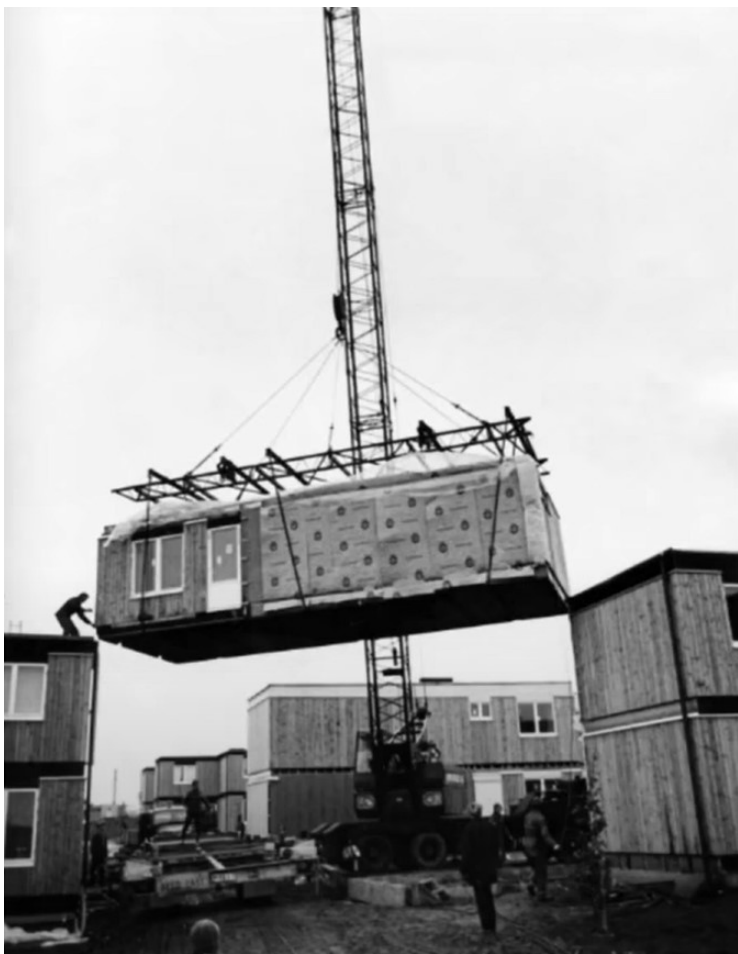
Det sista radhuset ställs på plats med lyftkran 1972. Källa: Bilder i Syd.
