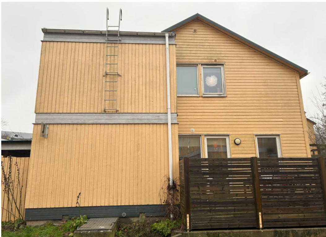
Möte mellan ursprunglig byggnad och tillbyggnad. Här syns även nedgång till kulvert och hur sargen är överhängande betongsockeln med ursparningar för ventilation.
