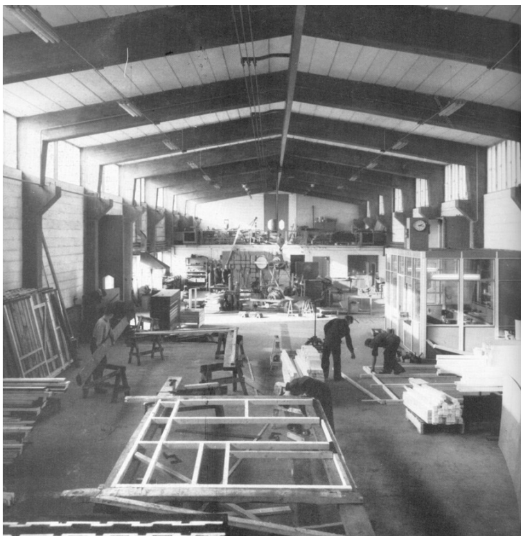
Produktion av Lunnavillan 1960-tal. Prefabricering inomhus på fabrik var nytt vid tiden och möjliggjorde tids- och kostnadseffektivt byggande. Källa: Kulturportal Lund.
